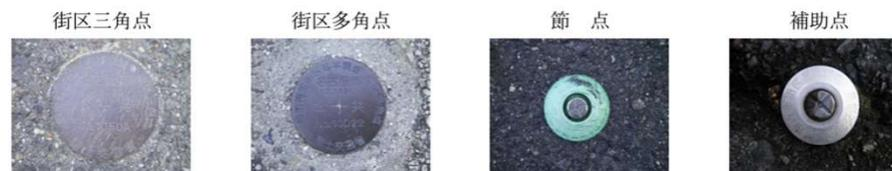
街区基準点は世界測地系の座標をもった測量用標識であり、この基点から目標物を測定することで地球上における正確な位置を知ることができます。
